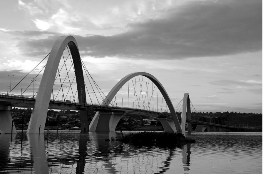
Ponte JK, Brasília. Fonte: http://fotosbsb.com.br/photo/45-ponte-jk-ao-amanhecer/
